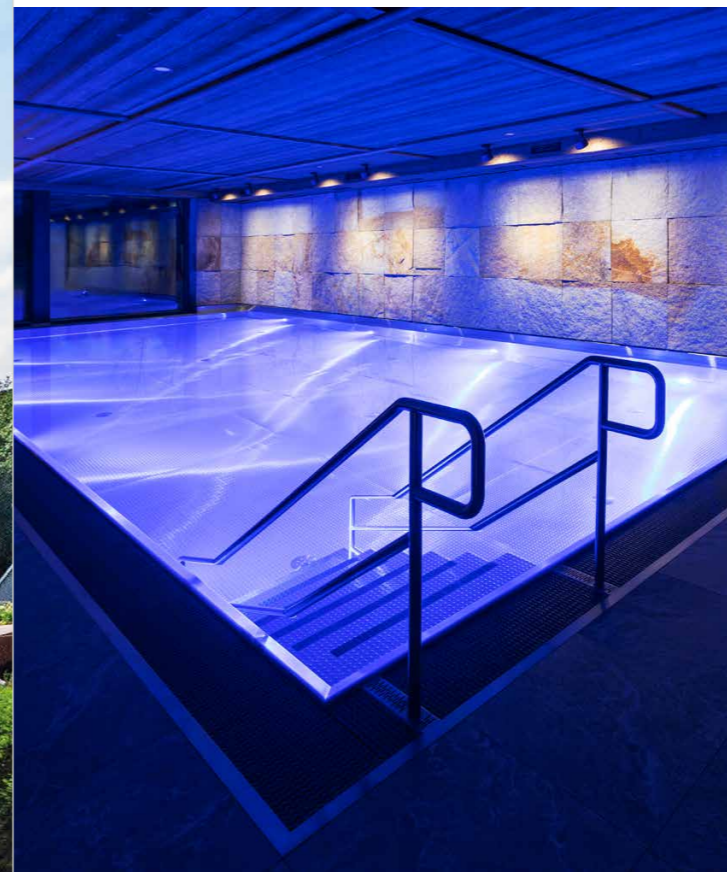
Prémiový přelivný nerezový plavecký bazén v krkonošském resortu Aldrov
